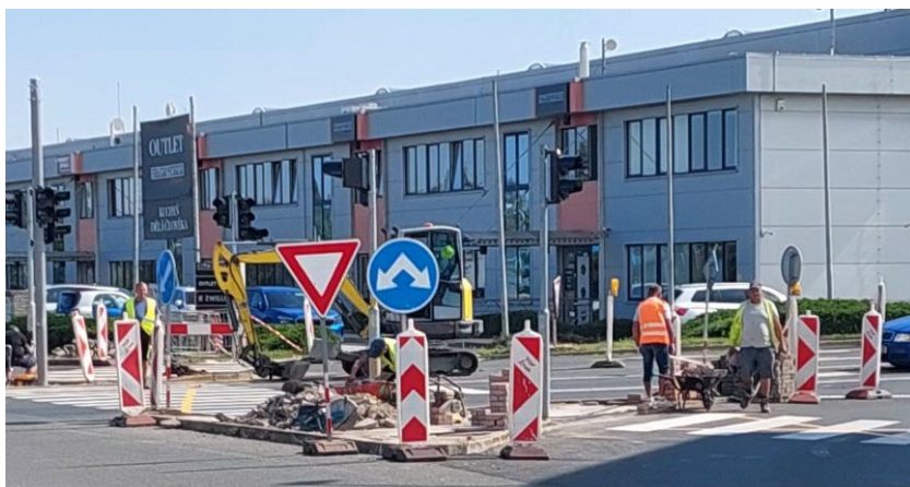
▲ Výměna světelného signalizačního zařízení v křižovatce Průhonická
