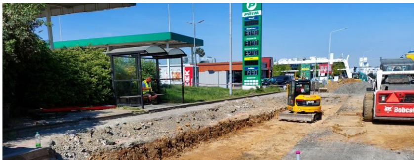
▲ Sanace podloží zálivu autobusové zastávky Čestlice, nákupní zóna
