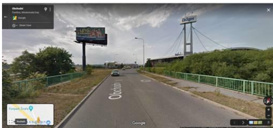
Obr.3 – Věž Dräger před Hornbachem (pata je na výšce 315 m n.m, výška stojanu cca 22m, celkem 337 m n.m.):
