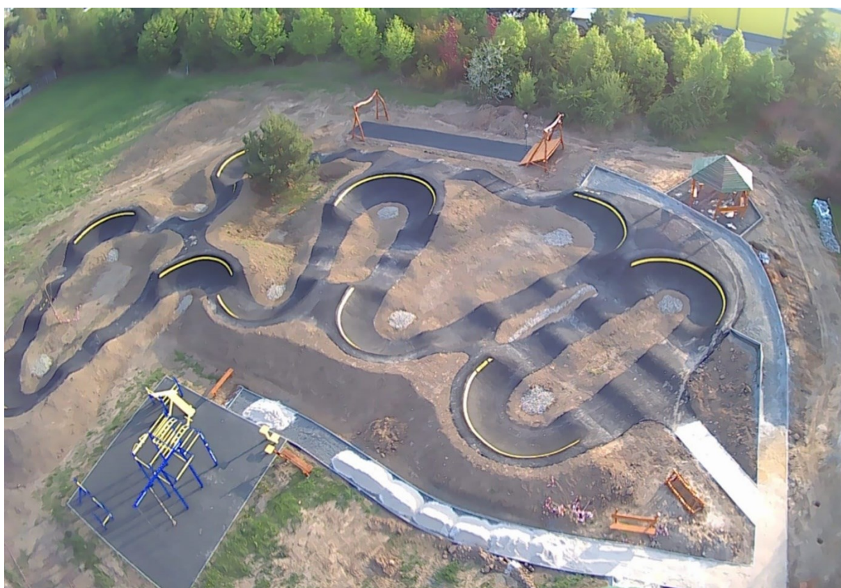
Obrázek 7: Vybudované nové sportoviště – pumptrack – za ulicí Polní
