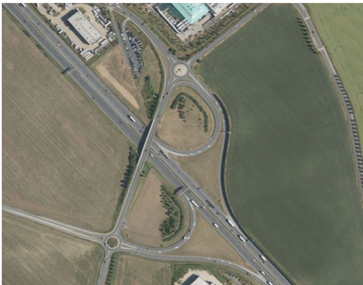
Obrázek 3: Dálniční křižovatka Exit 8, Čestlice
